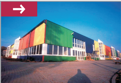
Betrieb D1 Dägeling
