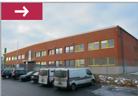
Betrieb D3 Dägeling
